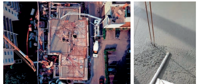
En vue de la mise en œuvre de son BPE pour les dalles, le plancher, les voiles et les fondations de la résidence Le Onze, Unibéton a développé 4 formulations spécifiques de béton intégrant des gravillons recyclés. Des courbes granulométriques ont été réalisées sur toute la durée du chantier.
